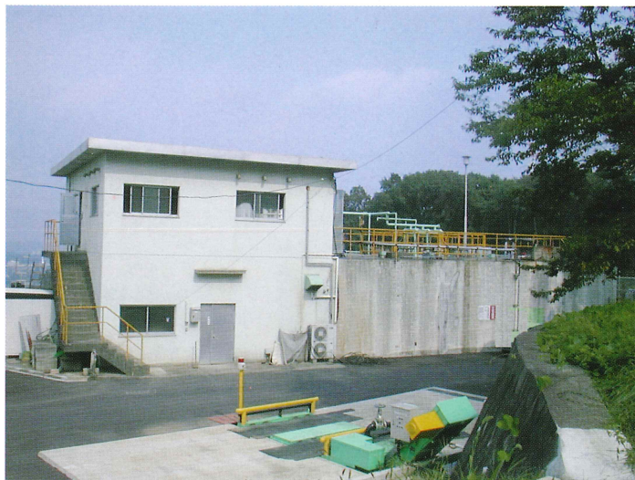
浸出水処理棟及び洗車設備
